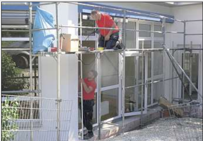
Die Handwerker haben mit Feuereifer die letzten Arbeiten erledigt, damit der Pavillon zur offiziellen Einweihung fertig ist.
