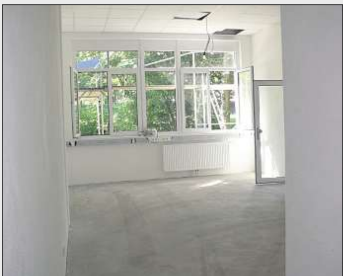
Der Raum für die Geschäftsstelle war beim Fototermin noch nicht fertig. Man kann aber schon erkennen, dass hier ein schönes Büro mit Blick ins Grüne entsteht. Am Samstag wird es fertig sein.
